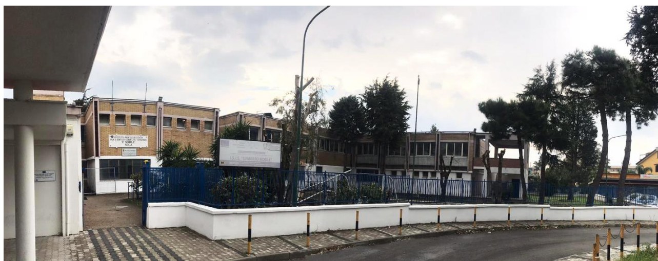
SEDE VIALE GARIBALDI
